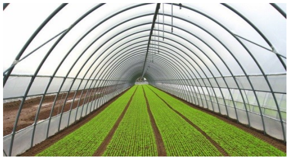
Şəkil 2.3. İriqabaritli tunel qurğuları
