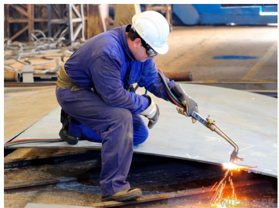
Şəkil 6.23. Qaz qaynağı
