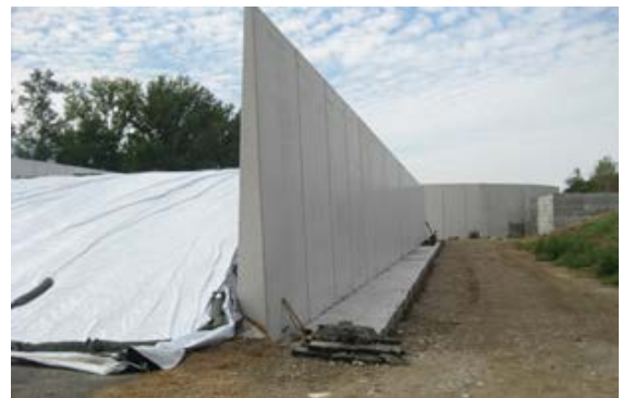
Şəkil 5.30. Xəndəklərin çadırlarla örtülməsi
