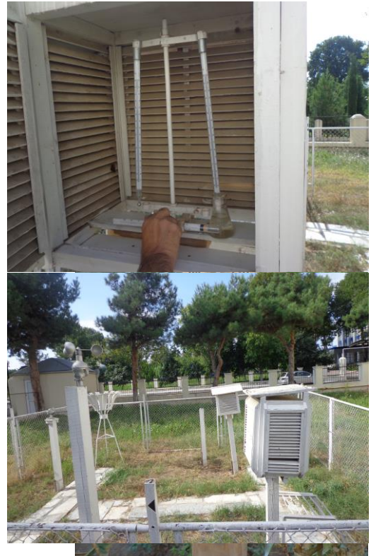
Şəkil 1.1. Havanın temperaturunu ölçmək üçün termometrlər quraşdırılmış budkalar
