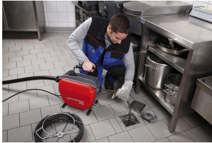
Şəkil 4.18. Trapın təmizlənməsi
