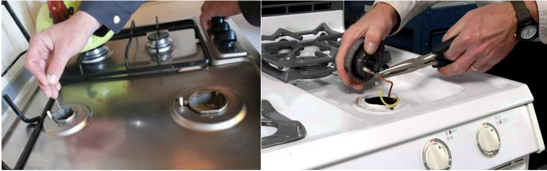
Şəkil 5.6. Qaz odluğunun təmiri
