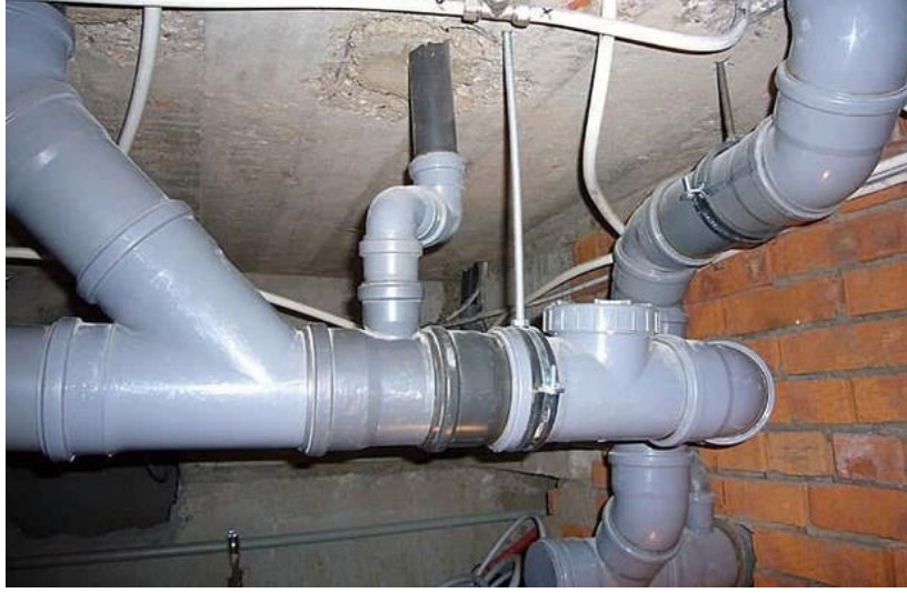
Şəkil 2.10. Kanalizasiya borularının birləşməsi
