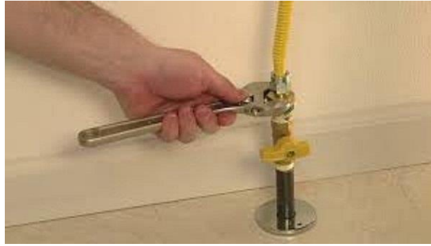
Şəkil 5.5. Qaz kranının bərkidilməsi
