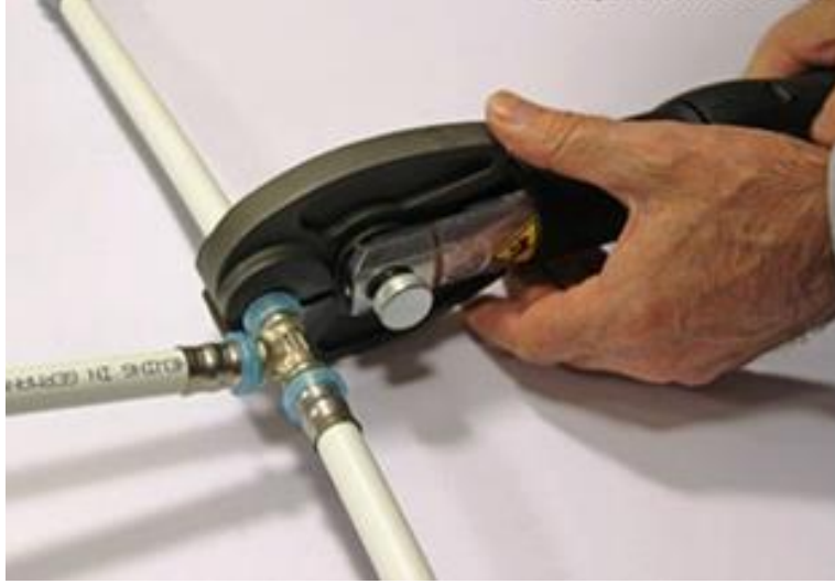
Şəkil 2.19. Armaturların dəyişdirilməsi
