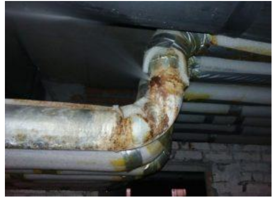
Şəkil 2.13. Boruda çürümə və sızma
