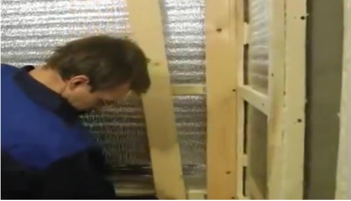
Şəkil 3.22. Sonrakı üzlük taxtalar bərkidilir
