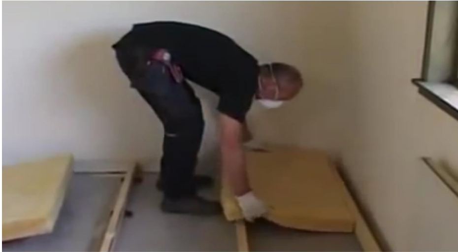
Şəkil 1.51. Laqaların arası istilik izolə qatı ilə doldurulur
