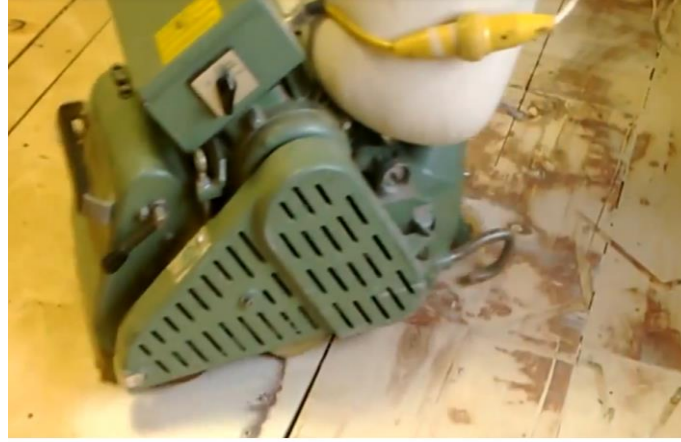
Şəkil 1.70. Döşəmə əsasları tam hamarlanır
