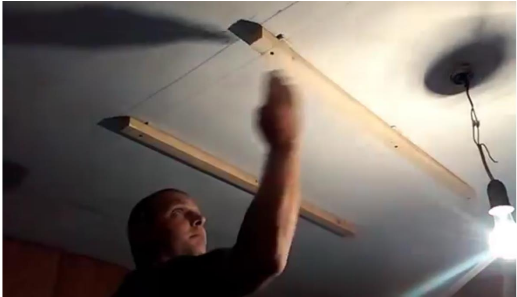
Şəkil 2.11. Bruslar beton tavana bərkidilir
