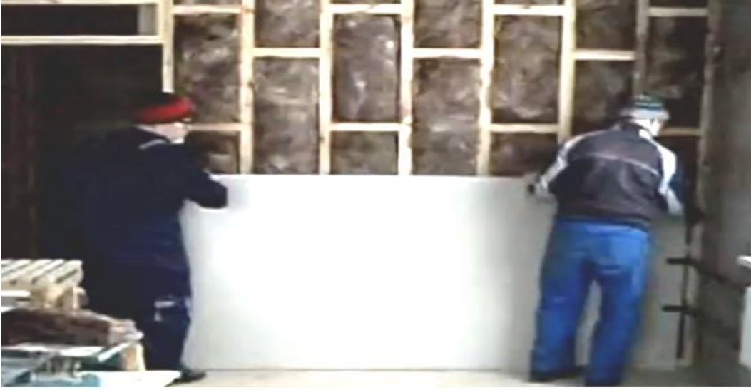
Şəkil 3.14. Divarın üzlənməsi
