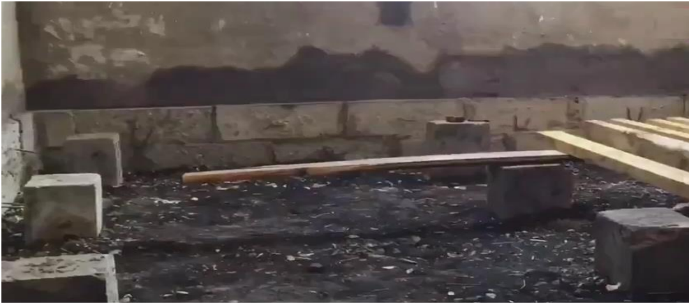
Şəkil 1.61. Tumbalar hazırlanır
