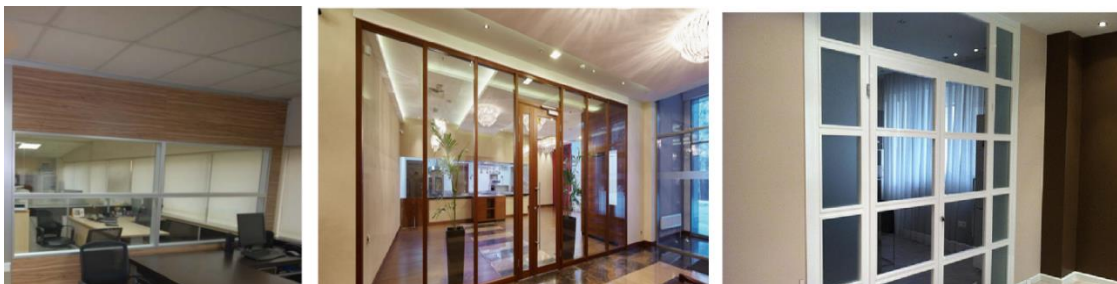
Şəkil 3.4. Metal profilli karkas və şüşə arakəsmələr
