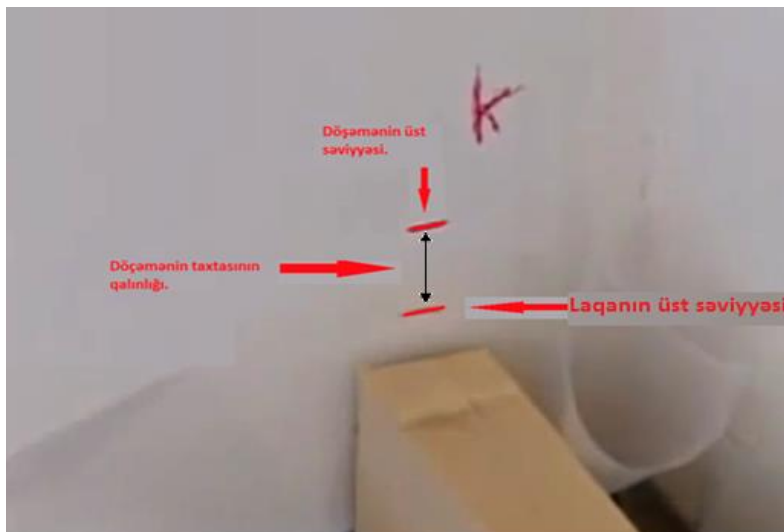
Şəkil 1.45. Döşəmə və plintusun səviyyələri qeyd olunur
