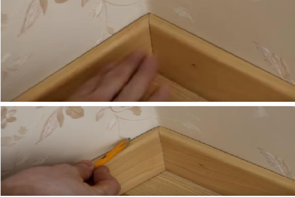
Şəkil 1.98. Plintusların küncə qoyulub yoxlanması
