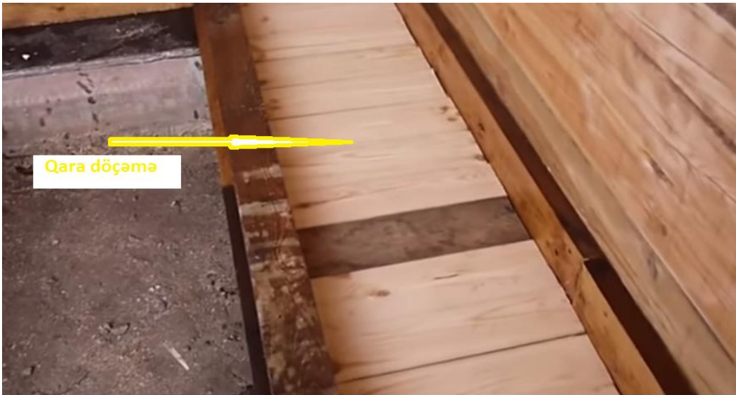
Şəkil 1.63. Qara döşəmənin düzülməsi
