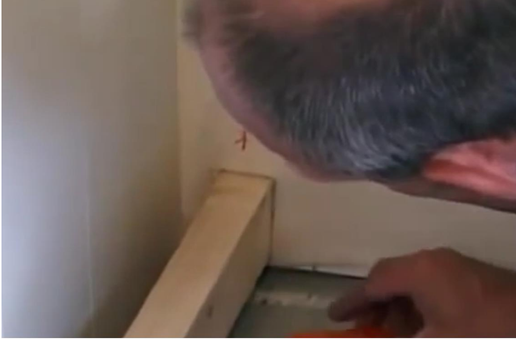
Şəkil 1.48. Əks divarda laqanın qoyulması
