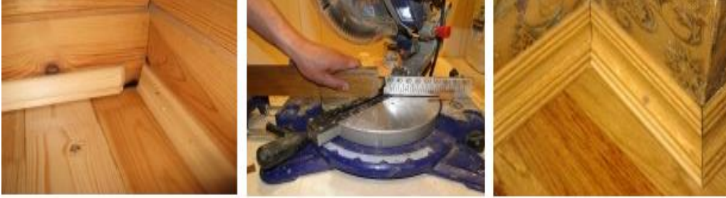
Şəkil 1.96. Plintusların quraşdırılması
