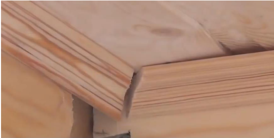
Şəkil 2.21. Qaltellərin vurulması
