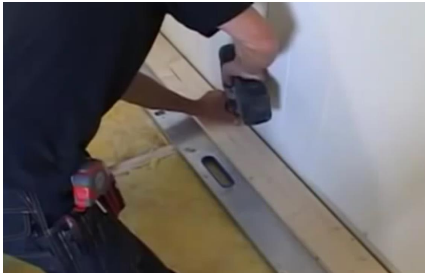
Şəkil 1.54. Taxtanın düzgünlüyü yoxlanılır və kənarları da şurupla bərkidilir
