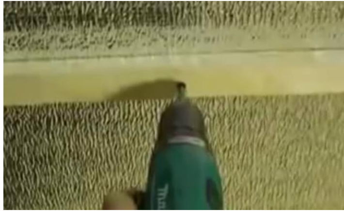
Şəkil 3.15. Reykaların divar karkasına bərkiməsi
