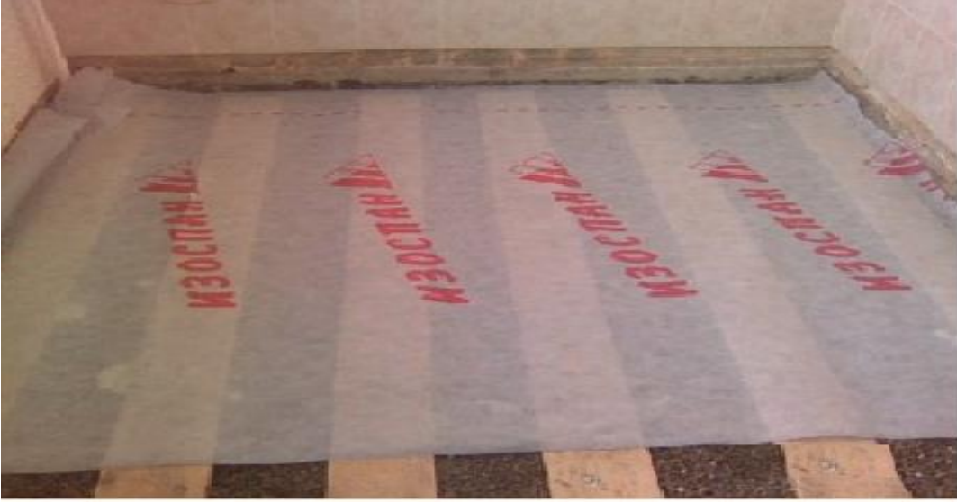
Şəkil 1.82. Laqaların üzərinə izolə qatı sərilir
