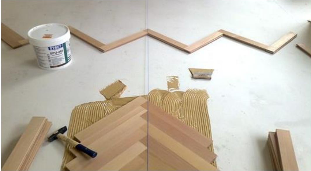
Şəkil 1.75. İlk cərgənin düzülməsi
