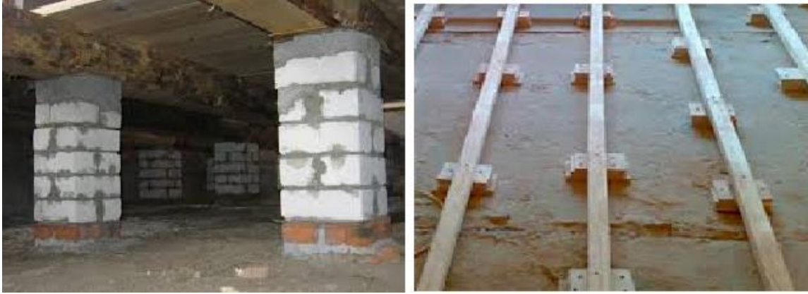
Şəkil 1.59. Tumbaların üzərində qurulan döşəmələr
