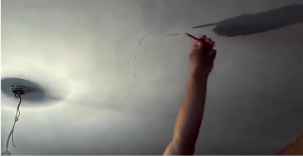
Şəkil 2.10. Bərkimə elementlərinin yerləri işarələnir
