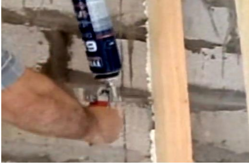
Şəkil 3.12. Ara boşluqların köpüklə doldurulması
