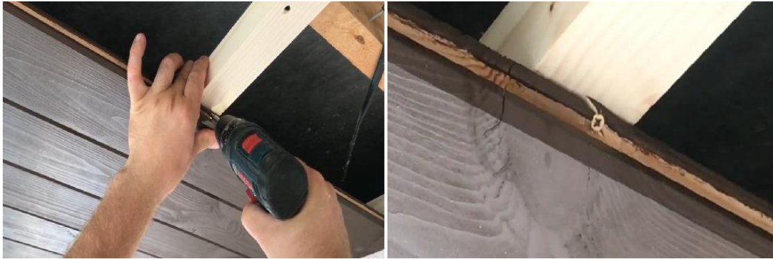
Şəkil 2.19. Üzlük taxtaların karkasa vurulması
