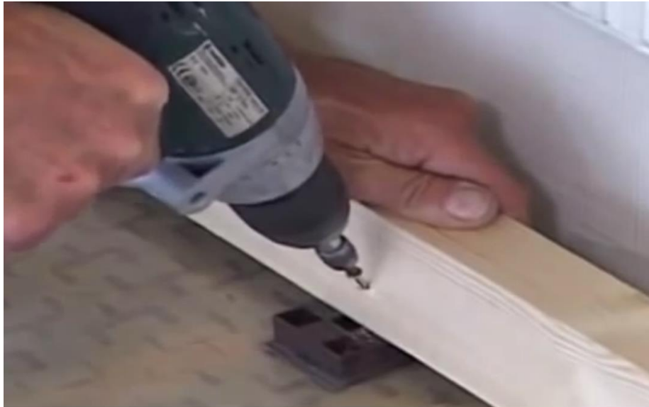
Şəkil 1.49. Qoyulan laqalar şuruplarla montaj pazlarına bərkidilir
