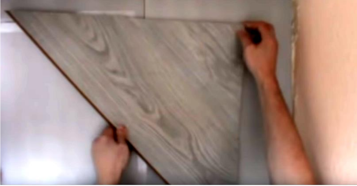
Şəkil 1.92. İlk künc laminatın qoyulması
