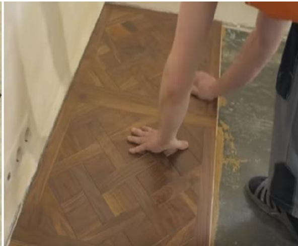
Şəkil 1.81. Lövə parketlərin düzülmə yerləri müəyyənləşdirilir
