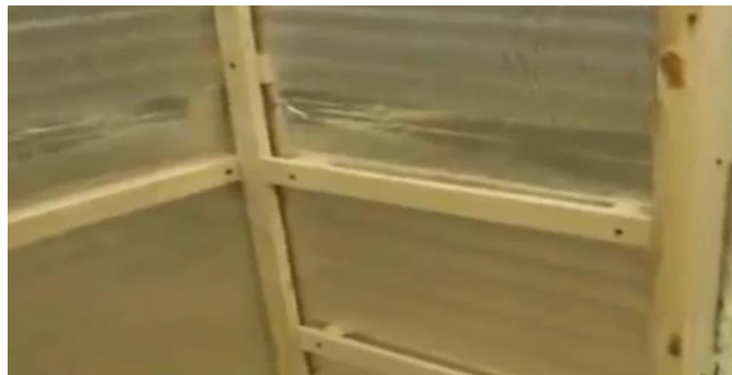
Şəkil 3.19. Bütün divar boyunca şəbəkənin hazırlanması
