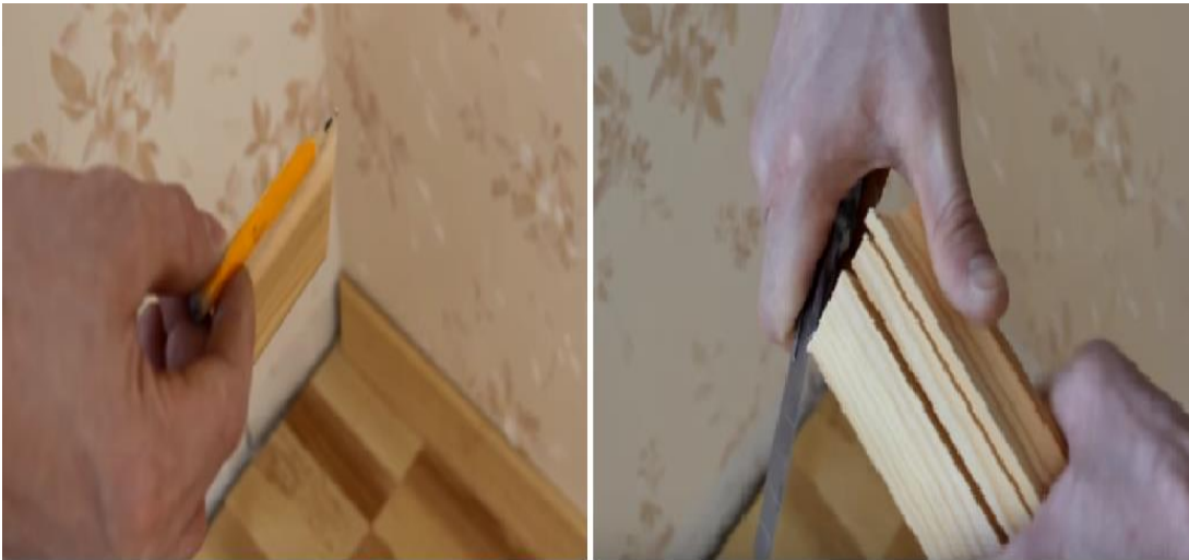
Şəkil 1.99. Plintusların künclərinin yonulması
