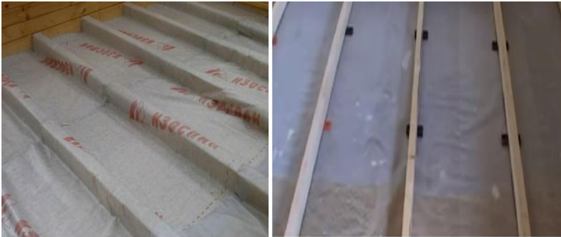
Şəkil 1.65. İzolə materialının üstündən buxardan izolyasiya klyonkası çəkilir və onun üstündən laqalar düzülür
