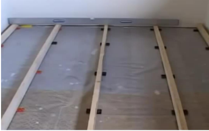
Şəkil 1.50. Qalan laqalar tarazla qoyulur və pazzlara bərkidilir
