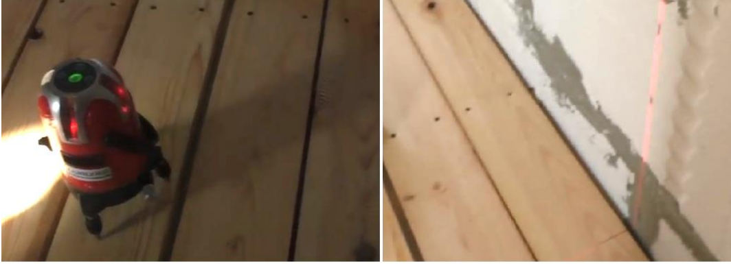
Şəkil 3.8. Arakəsmənin konturu nişanlanır
