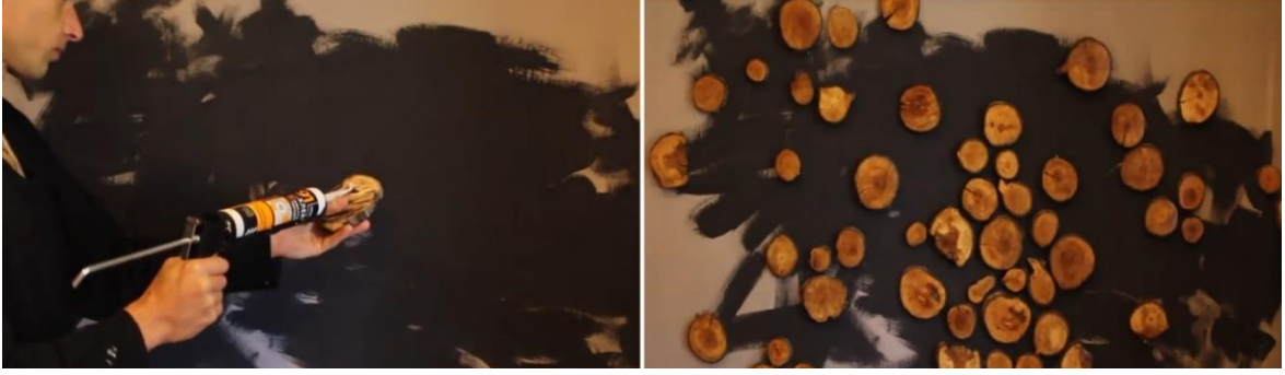
Şəkil 3.34. Halqalar divara yapışdırılır
