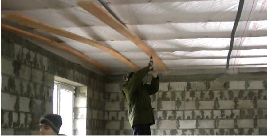
Şəkil 2.5. Tirlərə alt tərəfdən qaralama tavan vurulur
