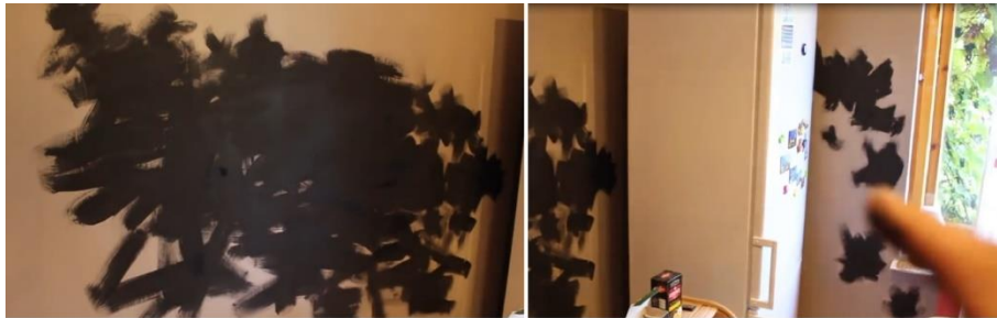
Şəkil 3.33. Divar hissəsinin fonu rənglənilir
