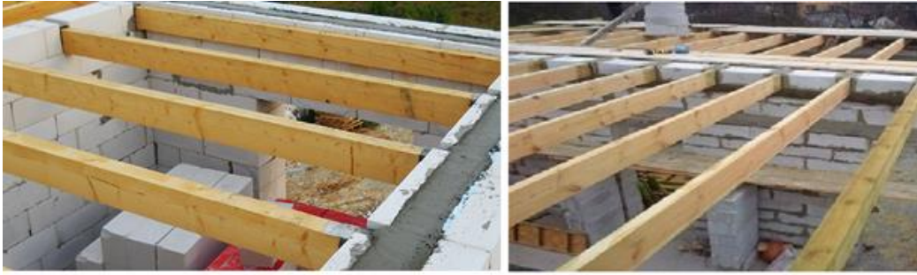
Şəkil 2.3. Tirlərin divar üzərinə qoyulması
