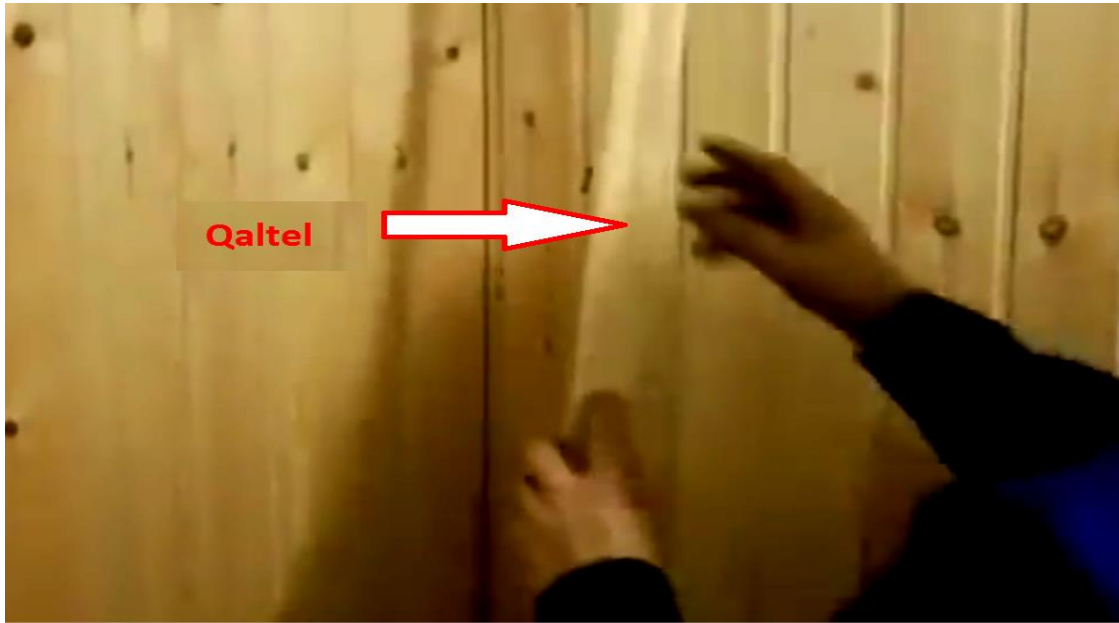
Şəkil 3.23. Künclərə taxta qaltellərin vurulması
