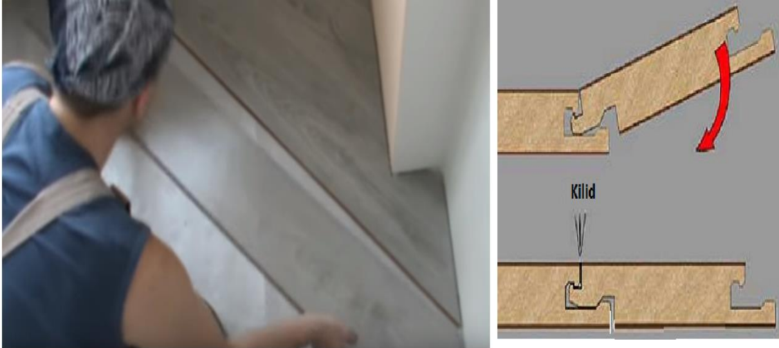
Şəkil 1.93. Qalan laminatlar düzülür və onlar bir-biri ilə kilidlə bərkidilir
