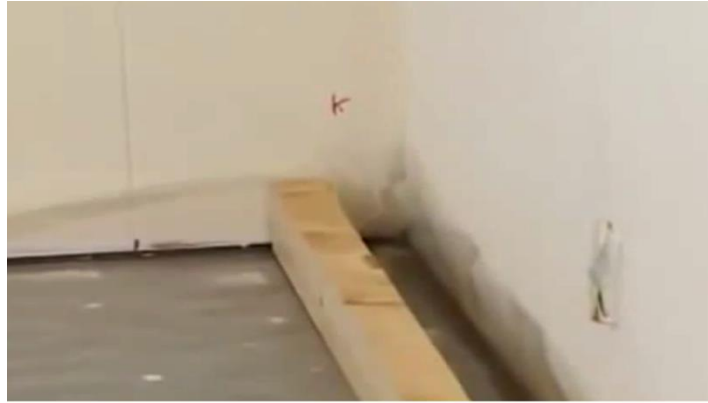
Şəkil 1.44. İlk laqanın qoyulması
