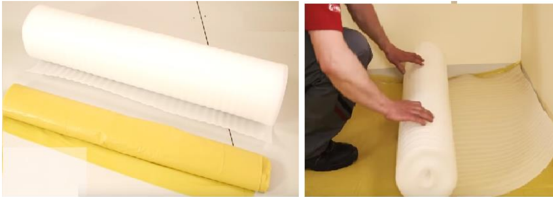
Şəkil 1.91. Laminat altı qatların sərilməsi
