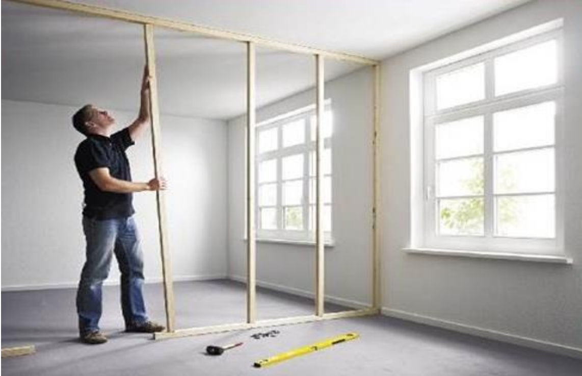
Şəkil 3.9. Karkas bruslarının qurulması
