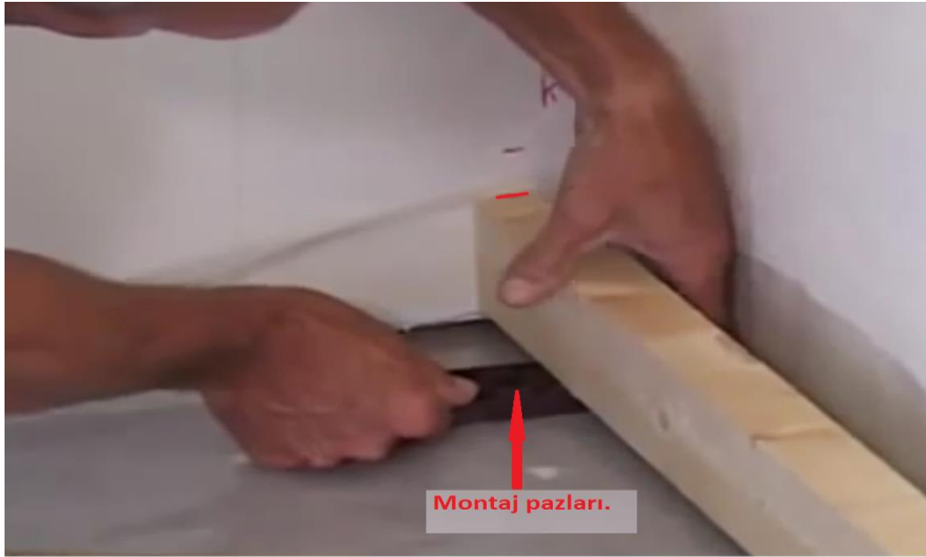
Şəkil 1.46. Laqalar qeyd olunmuş səviyyədə qoyulur.
