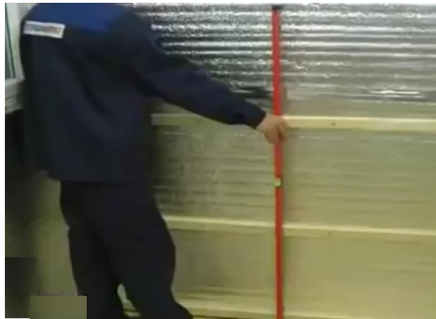
Şəkil 3.16. Şəbəkənin tarazlığının yoxlanması
