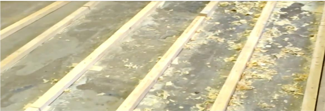
Şəkil 1.68. Laqaların düzülməsi
