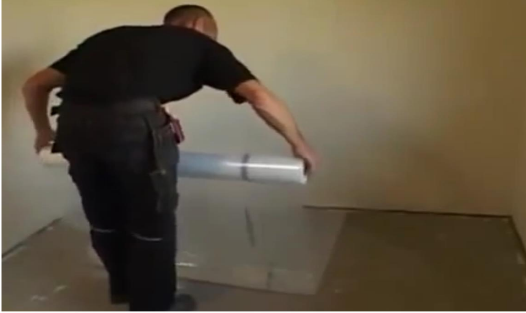
Şəkil 1.41. Beton döşəməyə polietilen araqaatı çəkilir
