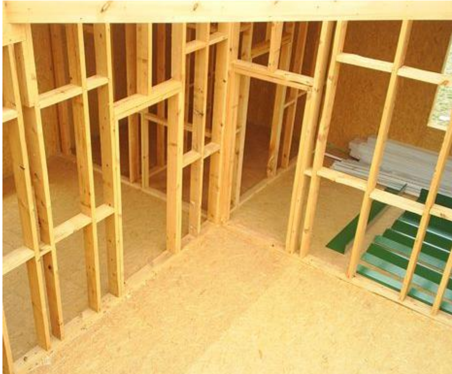
Şəkil 3.11. Qabırğaların bərkidilməsi
