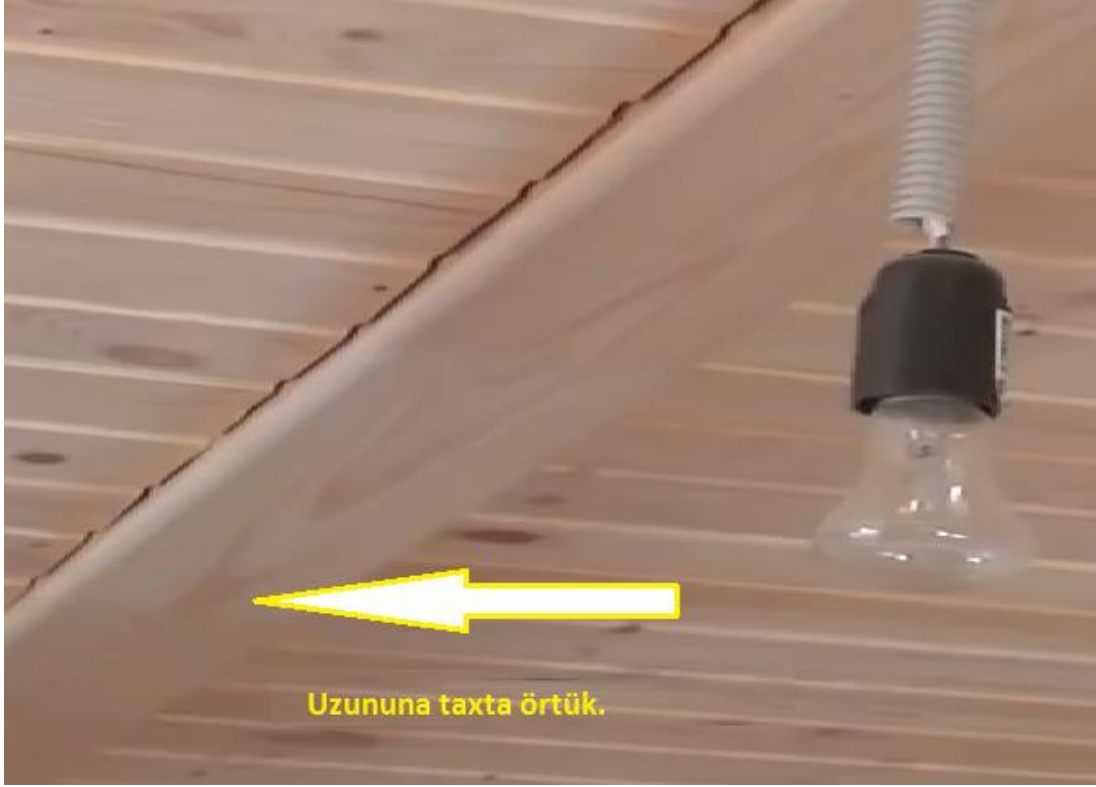
Şəkil 2.20. Kəllələrin birləşmə hissəsinin örtülməsi
