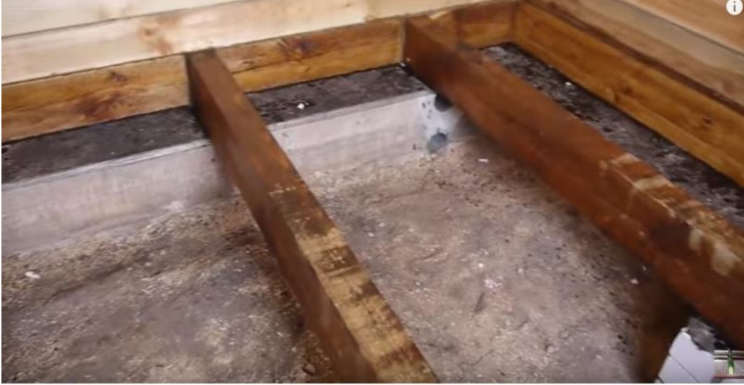
Şəkil 1.62. Tumbalar antiseptiklə rənglənilir
