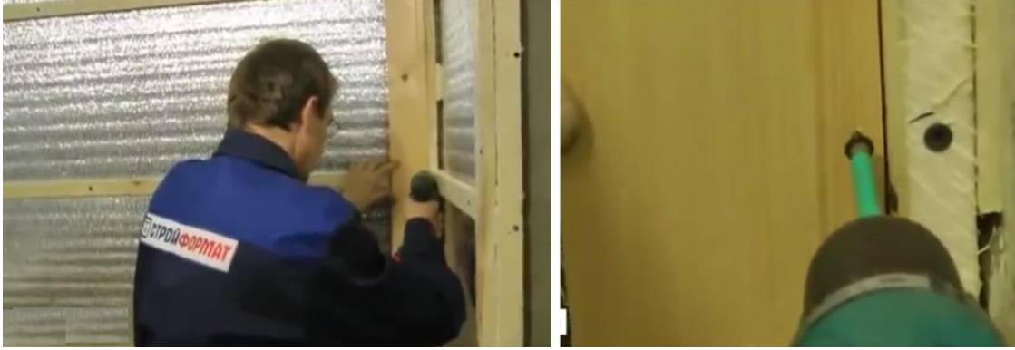
Şəkil 3.20. Birinci üzlük taxtanın vurulması
