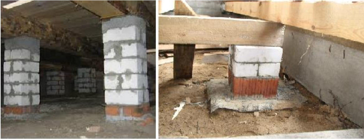
Şəkil 1.36. Tumbaların üzərində qurulan döşəmələr
