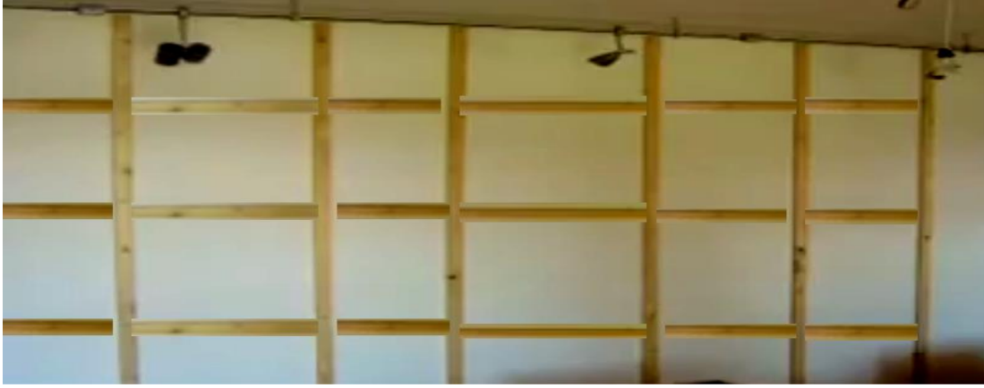
Şəkil 3.24. Divarda karkasın qurulması
