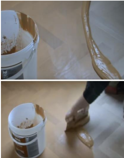
Şəkil 1.77. Döşəməyə mastika çəkilir
