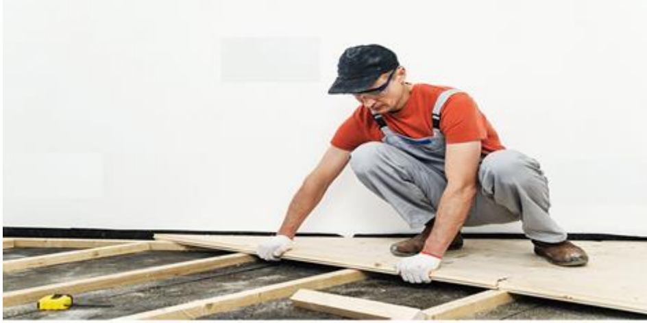
Şəkil 1.35. Beton əsasin üzərində qurulan döşəmələr
