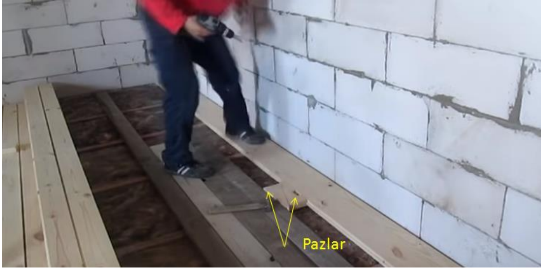
Şəkil 1.57. Döşəmə taxtaları pazlar vasitəsi ilə sıxılaraq laqara bərkidilir
