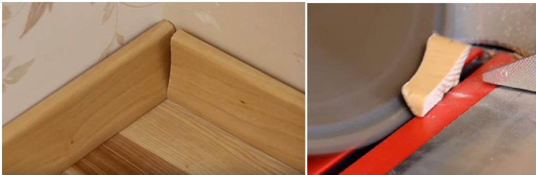
Şəkil 1.97. Plintusların künc üçün kəsilməsi
