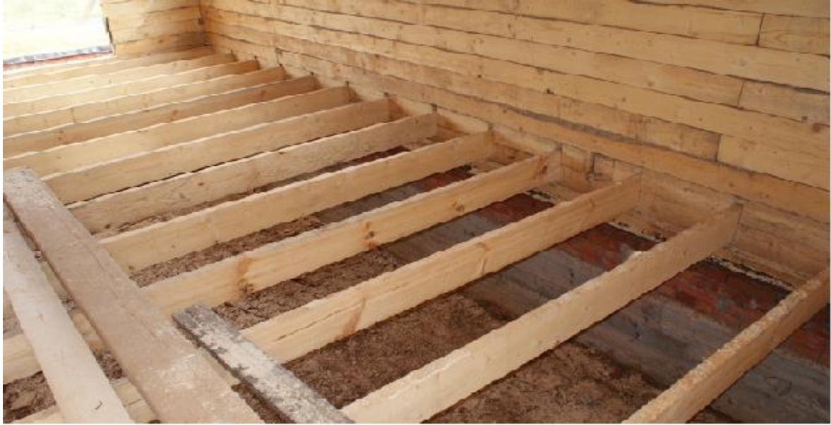
Şəkil 1.37. Tirlərin üzərində qurulan döşəmələr
