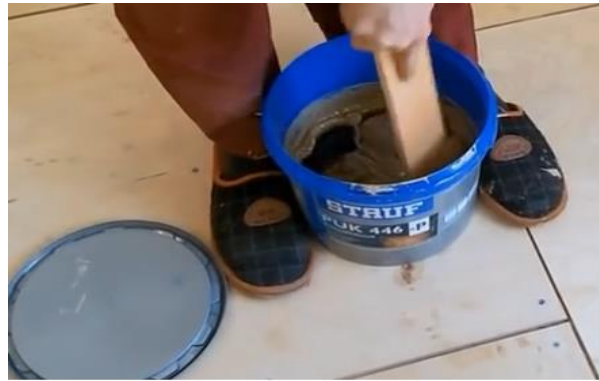
Şəkil 1.71. Parket yapışqanının hazırlanması
