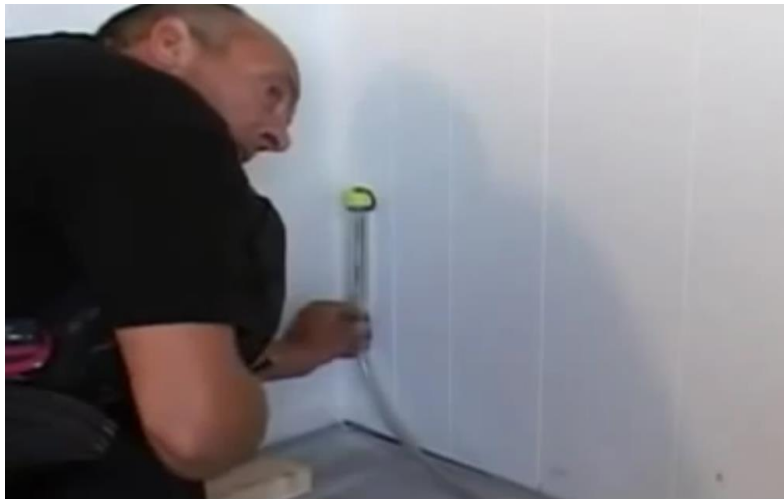
Şəkil 1.47. Laqanın üst səviyyəsi digər divarlara da keçirilir
