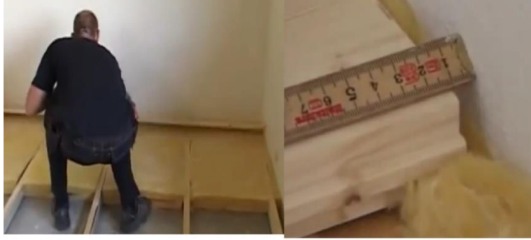
Şəkil 1.52. Birinci döşəmə taxtası qoyulur
