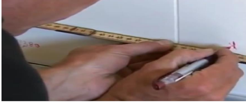
Şəkil 1.43. Laqaların yerləri divarda qeyd olunur.
