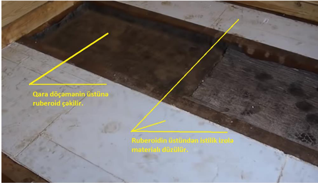
Şəkil 1.64. Qara döşəmənin üstünə ruberoid çəkilir və istilik izolə qatı düzülür
