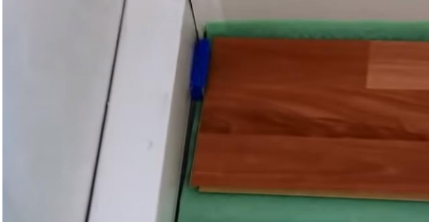
Şəkil 1.94. Birinci laminatın düzülməsi
