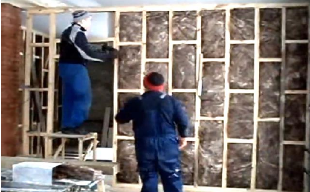
Şəkil 3.13. İzolə qatının qoyulması
