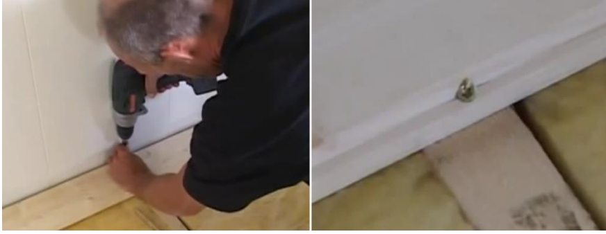
Şəkil 1.53. Döşəmə taxtasını qıraqlarından şurupla laqaya bərkidirlər
