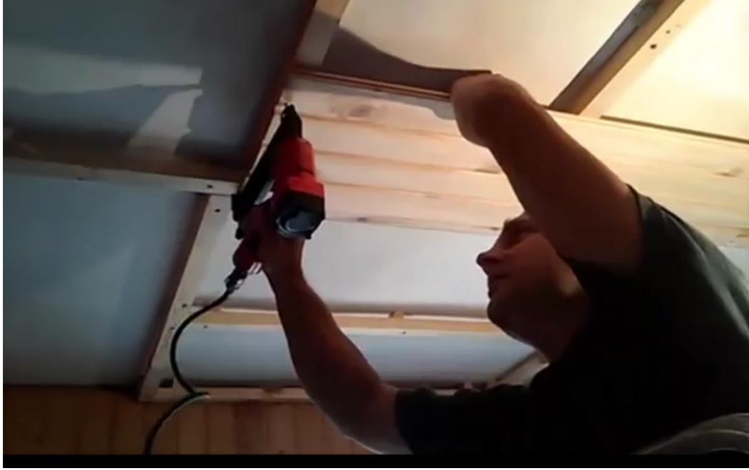
Şəkil 2.14. Üzlük taxtalar karkasa bərkidilir
