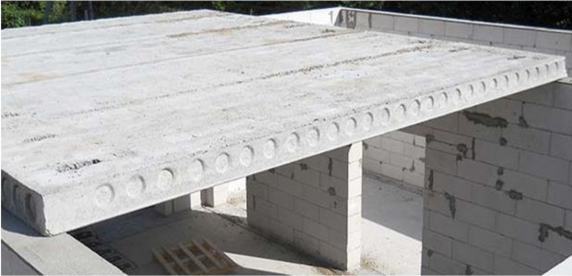
Şəkil 2.1. Dəmir-beton konstruksiyalı tavanlar
