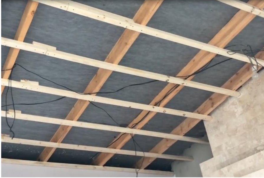
Şəkil 2.16. Karkasın hazırlanması
