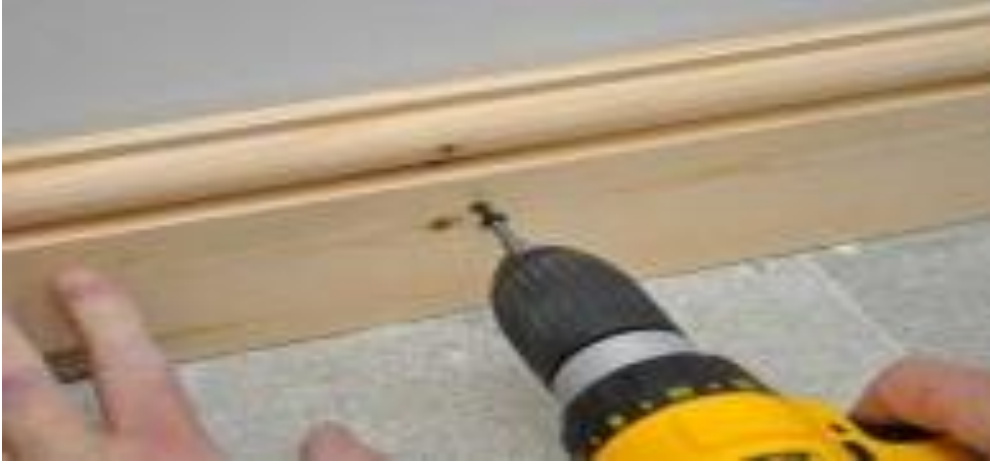
Şəkil 1.101. Plintusların bərkidilməsi
