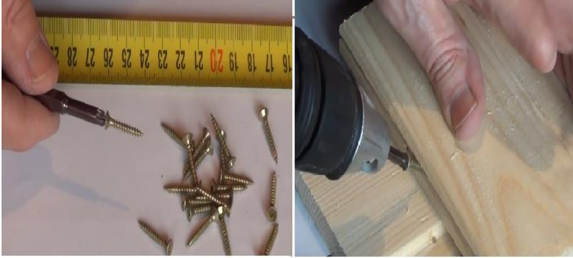
Şəkil 2.18. Üzlük taxtaların karkasa bərkidilməsi
