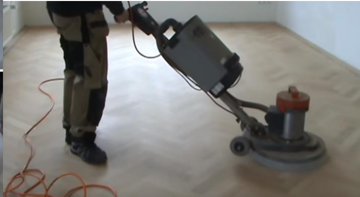
Şəkil 1.78. Döşəmə pardaqlanır
