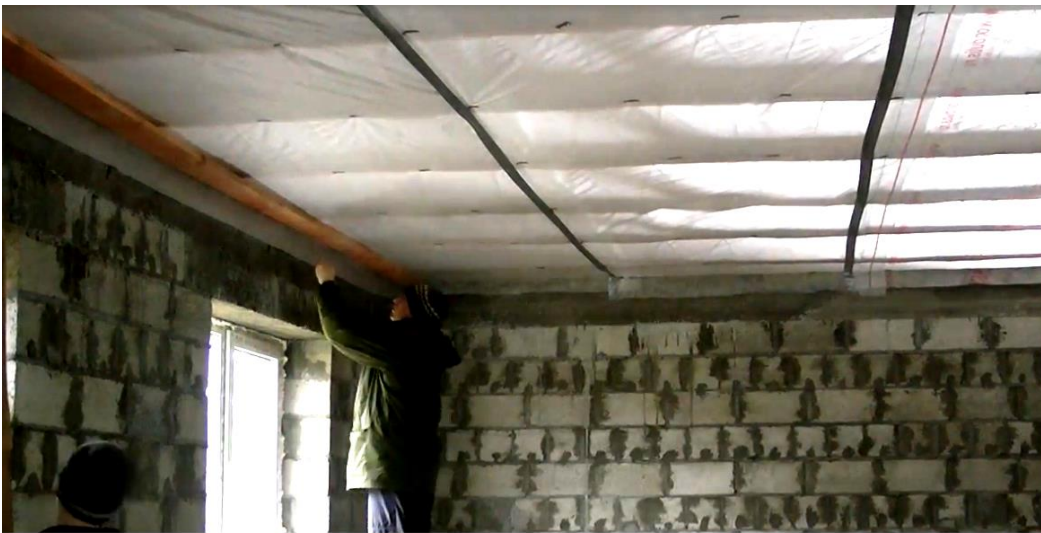
Şəkil 2.4. Tirlərə alt tərəfdən nəmliyə qarşı müşəmbə vurulur
