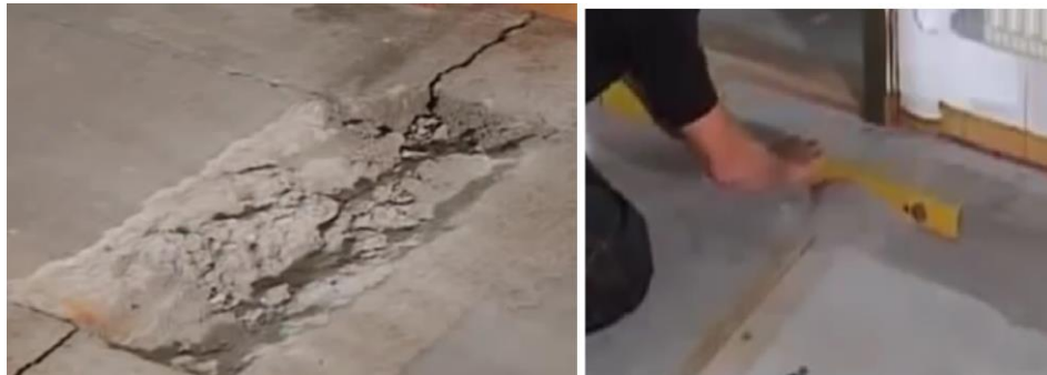
Şəkil 1.40. Beton döşəmədə olan çuxurlar sement məhlulu və ya narın qumla hamarlanır
