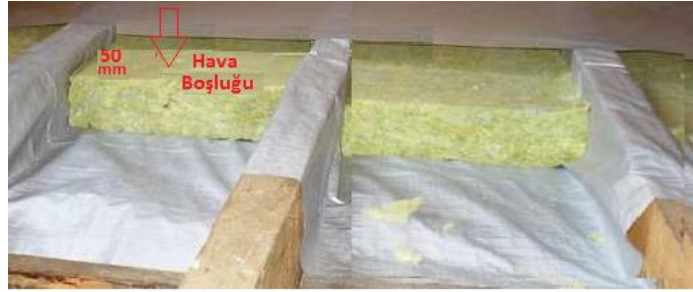
Şəkil 2.6. Buxardan və istilik izolə qatları döşənir
