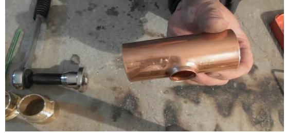
Şəkil 1.11. Qaynaq olunmağa hazır olan boru
