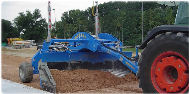
Şəkil 25. Traktorla aqreqat haslında işləyən hamarlayıcı
