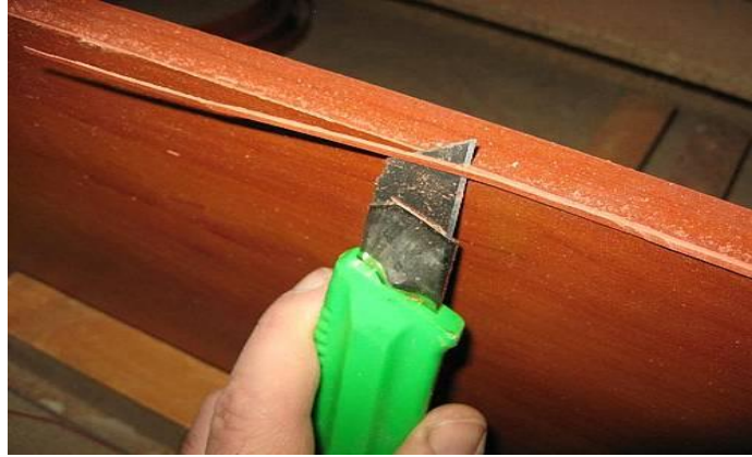
Şəkil 1.17. Bıçaqla bantın artıq hissələrinin kəsilməsi
