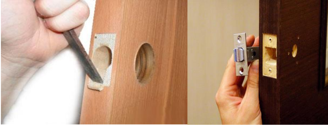
Şəkil 3.20. Ev şəraitində qıfilların montajı
