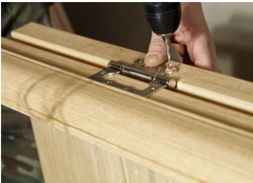
Şəkil 3.28. Vint yerlərinin burğulanması
