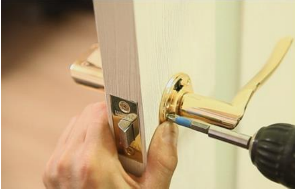
Şəkil 3.22. Dəstəklərin qapılara qoşulması
