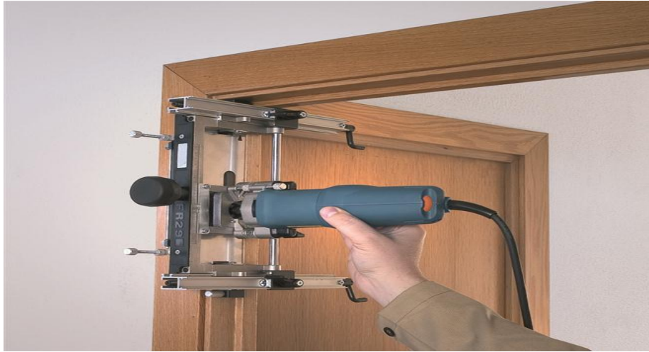
Şəkil 3.27. Frez dəzgahı ilə ilgə yerinin qazılması
