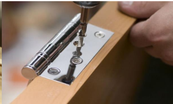
Şəkil 3.29. İlgənin vintlənməsi
