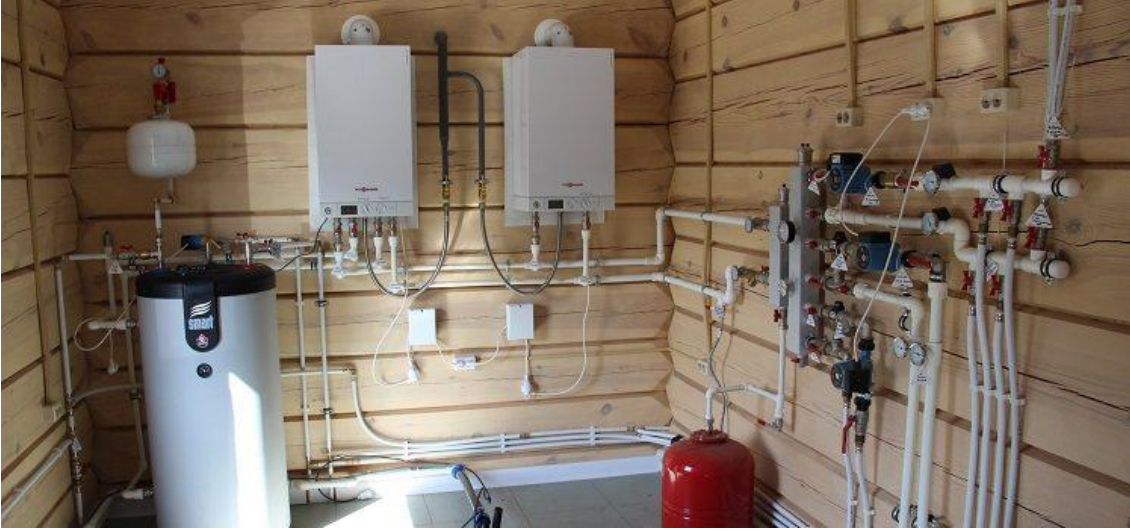
Şəkil 1.10. İsti su təchizatı sistemlərində istifadə olunan şüşə lifli PPR borular
