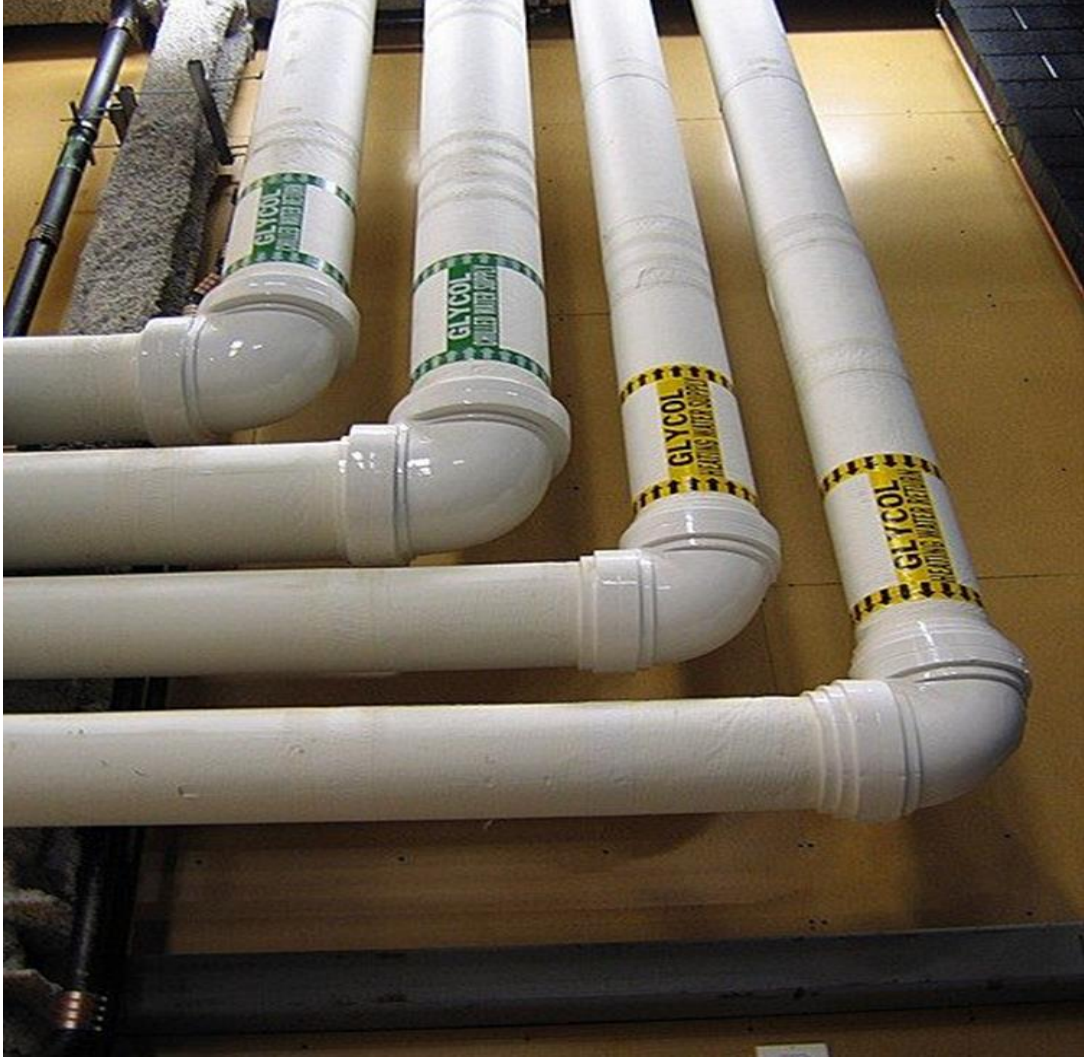
Şəkil 2.18. PVX borulardan quraşdırılmış yüksək təzyiqli su xətləri
