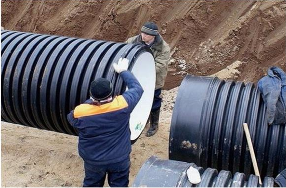
Şəkil 1.19. Qırçınlı boruların xəndəyə düzülməsi
