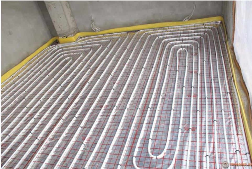
Şəkil 2.8. Döşəməalti isidici xətlərin çəkilməsi
