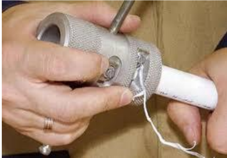
Şəkil 2.9. Qaynaqdan öncə metalloplastik boruların alüminium təbəqəsinin təmizlənməsi
