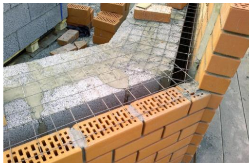
Şəkil 1.12. Divarların hörülməsi
