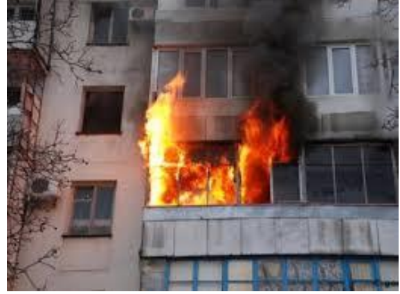
Şəkil 2.2. Plastik üzülükərin fəsadı
