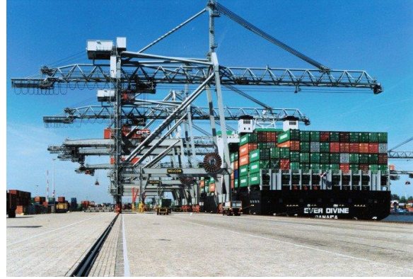
Şəkil 3.12. Relsli kran
