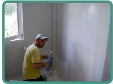
Şəkil 1.16. Suvağın divara çəkilməsi
