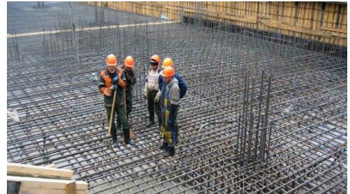
Şəkil 1.2. Bünövrənin qoyulması
